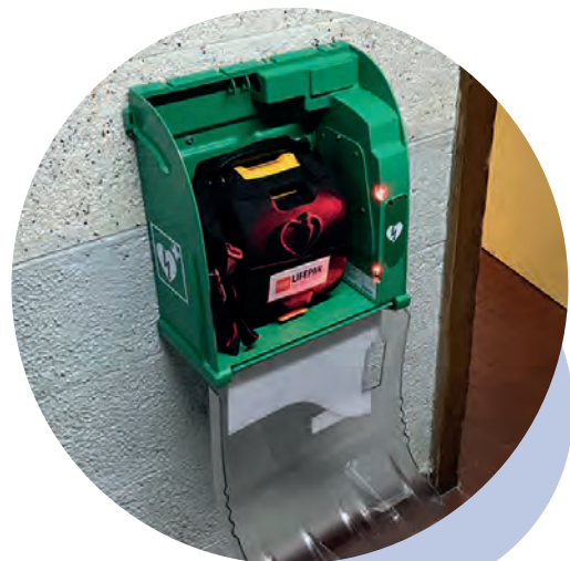
Installation de défibrillateurs
