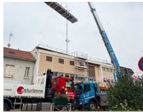
Evacuation des paraboles de l'ancien réseau câblé et pose de panneaux photovoltaïques
