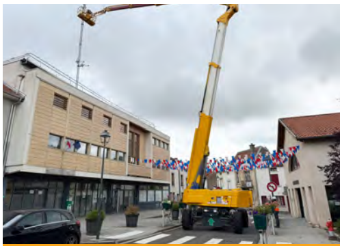
Entretien du système de vidéoprotection avec changement des antennes relais par la société Ineo Equans
