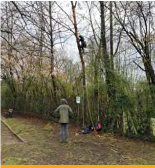
Sécurisation de la cour de l'école du Val des Faulx par élagage d'arbres dangereux
