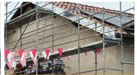
Nous avons profité de la mise en place de l'échafaudage pour les panneaux photovoltaïques de la Médiathèque pour redonner un coup de neuf aux volées de toit et procéder au remplacement de la planche de rive, qui montrait des signes de fatigue
