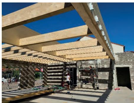
avec l'arrivée de la charpente. Le bâtiment étant ainsi hors d'eau et hors d'air, il ne reste plus qu'à laisser place à l'aménagement des installations techniques.
